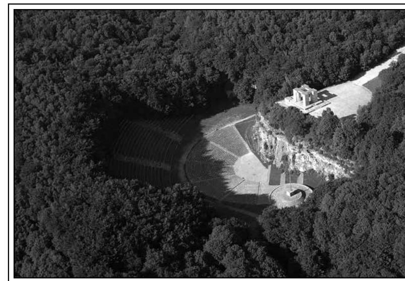
Fot. 33 Amfiteatr z lotu ptaka. (Gmina Leśnica)
