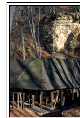
Fot. 46 Odslonięcie za dawnymi toaletami (MZ).
