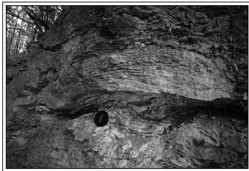
Fot. 38 Widoczne fałdy leżące (MZ).
